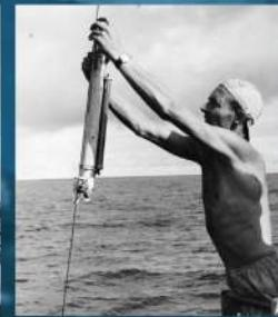
Работа с батометром перед спуском
