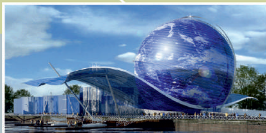
Строительство музейного центра «Планета Океан»
